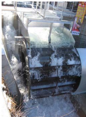
元気くん2号 流量：最大0.99m 3 /s 有効落差：最大3.5m 出力：22kW
