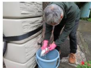
雨水タンク: 雨水を貯めて、植物に水やりしたり、農具を洗う。
