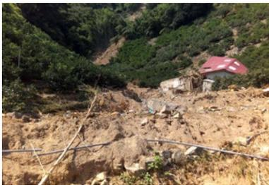
樹園地の崩壊とパイプライン、農業用モノレール、小屋の損壊
